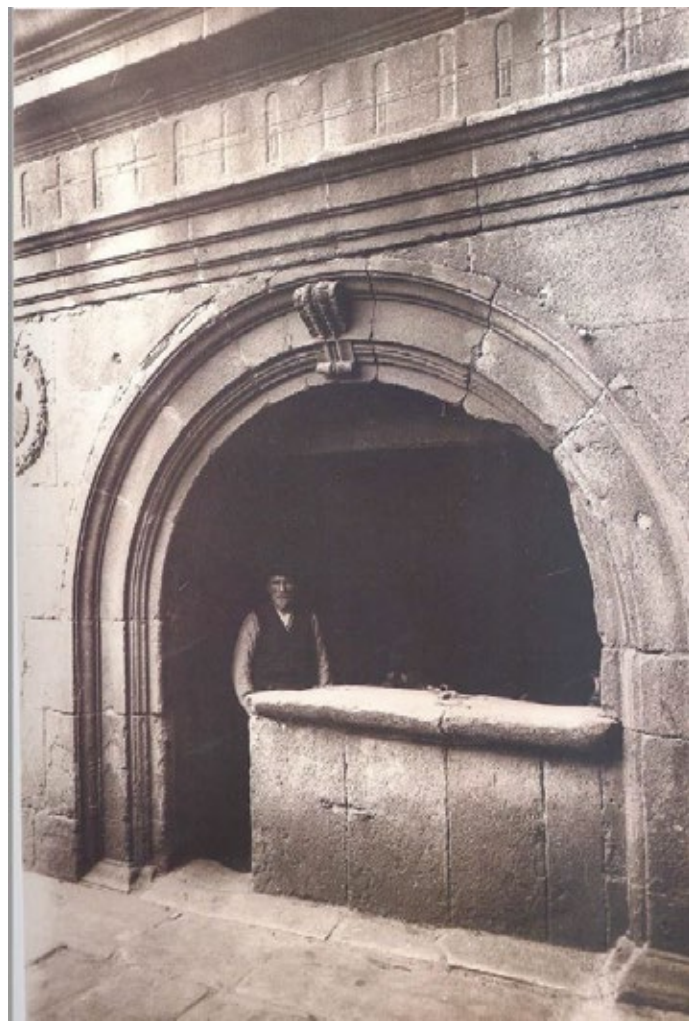
Prateiro na pratería nos baixos da Fachada do Tesouro Compostela. Memoria fotográfica. Facilitada por Pablo Costa Buján
