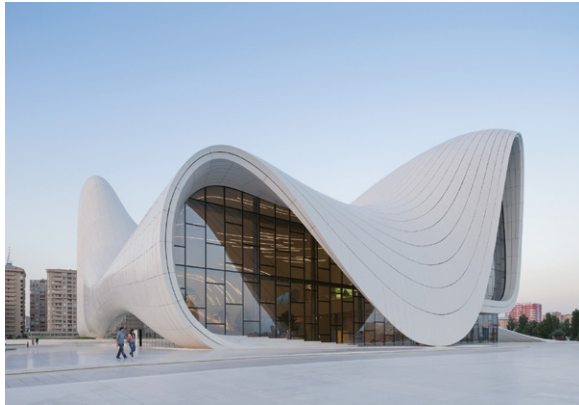
Zaha Hadid Centro Heydar Aliyev en Bakú, Acerbaixán, 2007 Foto: Iwan Baan
