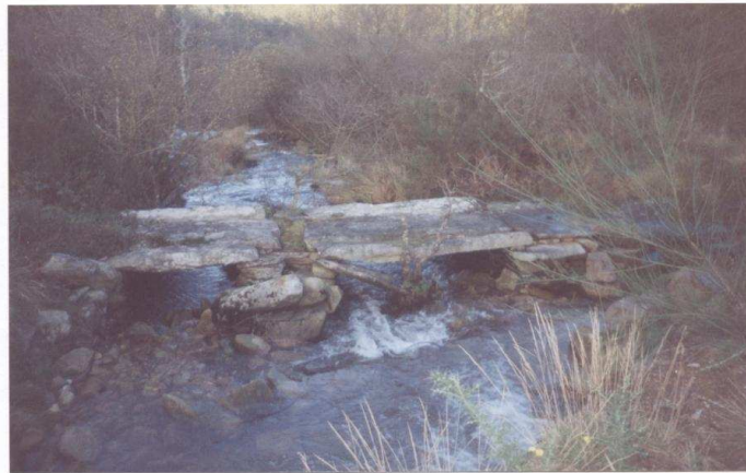
Ponte vella que atravesa o río do SIXTO á altura da fervenza do Rabiñoso que se atopa xusto augas abaixo da ponte.
